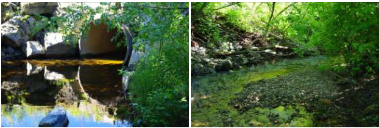
Figur 7. Til venstre utløpet av rør gjennom vei og til høyre fra samme punkt nedstrøms. Avstanden fra Lågen til dette røret er ca 150 m. Røret er 1 m i diameter og ca 6 m langt.
