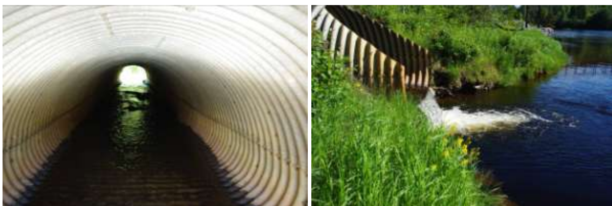
Figur 4. Kulverten sett ut mot Lågen og kulvertens utløp i Lågen.
